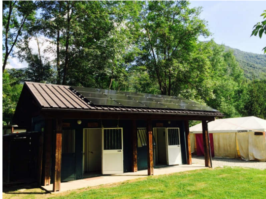
Realizzazione impianto Fv da 2,97 kWp con Cu-Q per una produzione di 4000 kWh/anno
